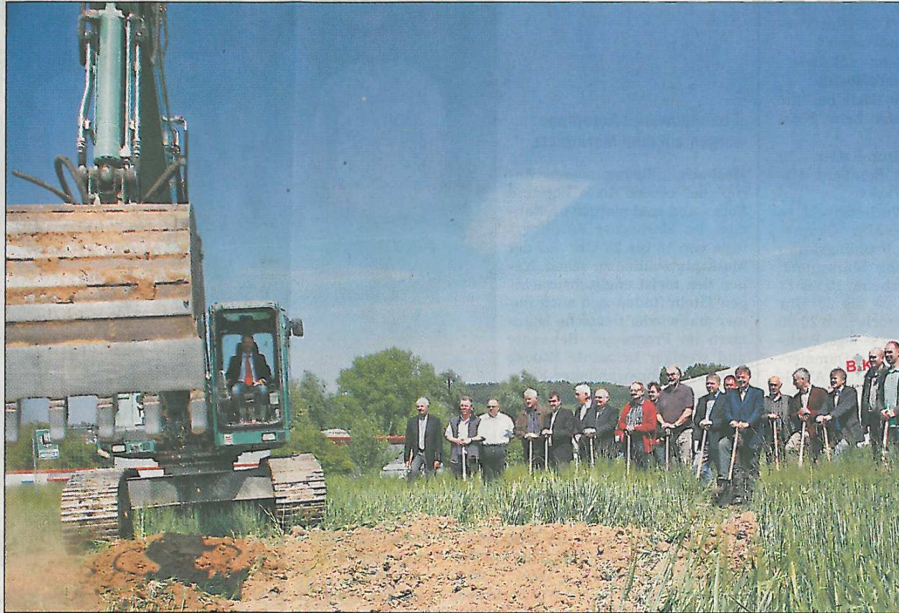
An die Spaten, auf den Bagger – das „Weiße Feld II“, aktuell noch gras- und gerstengrün, ist die Antwort der Stadt Mosbach auf die gute Nachfrage nach innenstadtnahen Gewerbegebieten. Foto: Ursula Brinkmann
